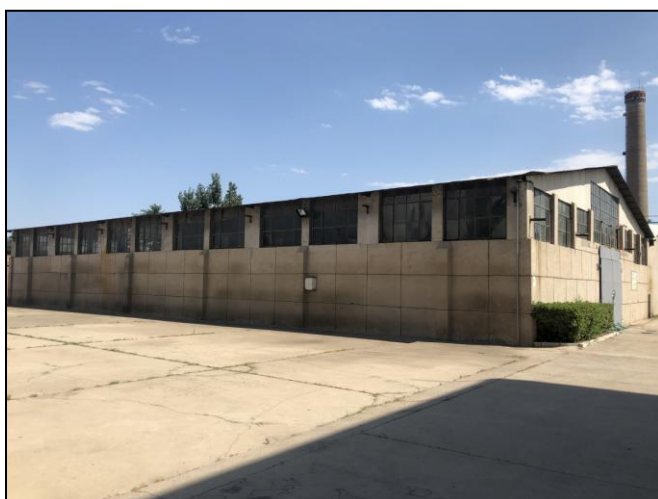
照片 9 原化工库
