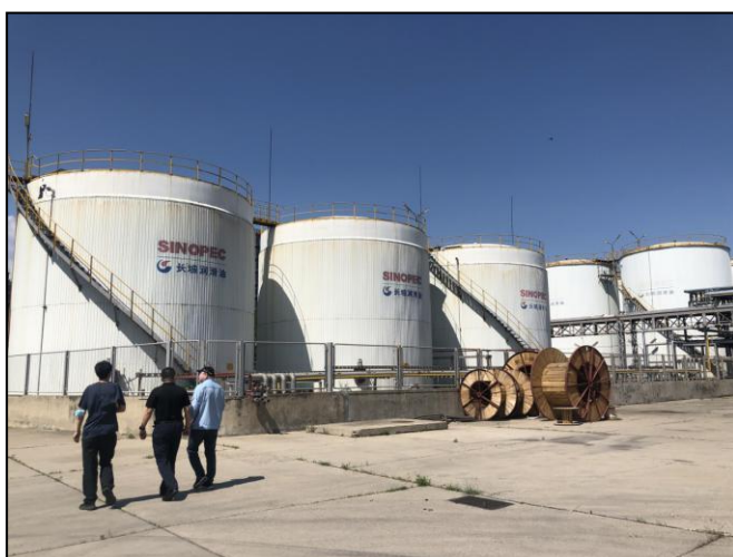
照片 4 原基础油罐区
