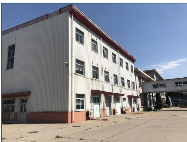
照片 3 原 OCP 厂房
