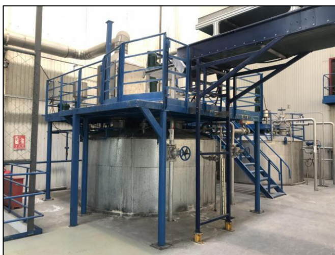
照片 13 防冻液调和区
