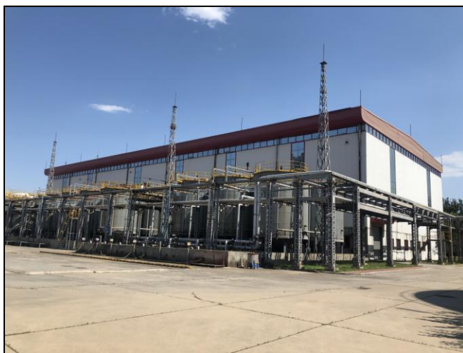
照片 5 原特油罐区
